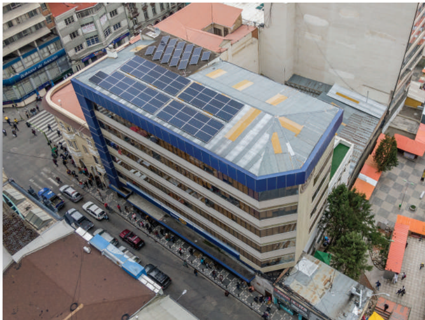
Paneles solares Edificio Principal La Paz
