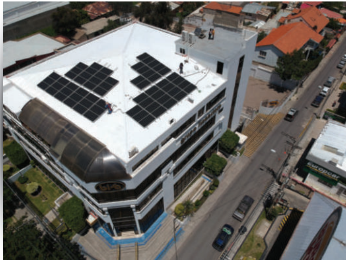
Paneles solares Edificio Principal Cochabamba
