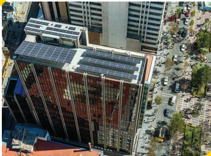
Paneles solares Edificio Nacional Banco BISA
